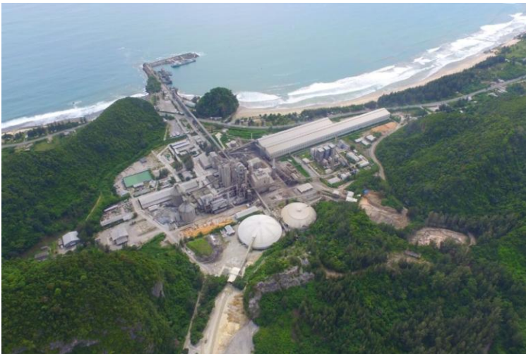
Gambar 6.2 Pabrik Semen Solusi Bangun Andalas (SBA) di Kab. Aceh Besar, Provinsi Aceh
